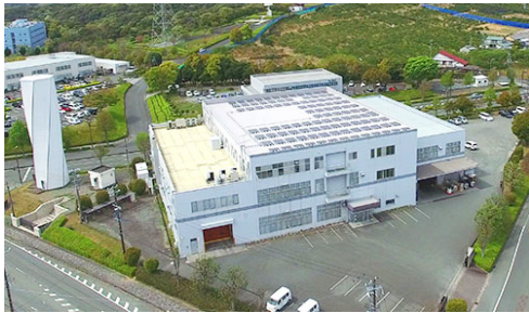
新都田工場 発電設備出力49.5kW 面積1,000㎡
