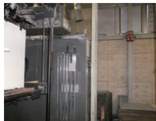
グラスウール剤を充填した防音パネルを設置
