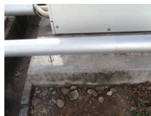
After 室外機改修により改善しました
