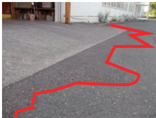
搬入出口の段差を補修することで、フォークリフト運転時の騒音対策をしました
