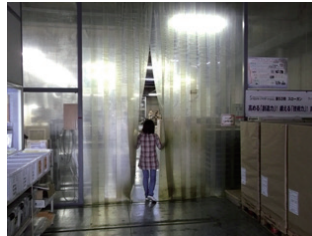
ゾーニングカーテン設置
