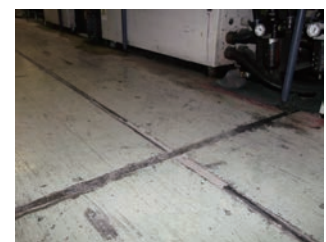
工場1階に防振ゴムを施工
