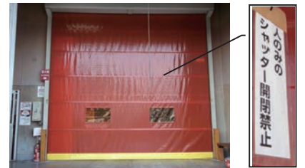
出入口シャッター利用制限
