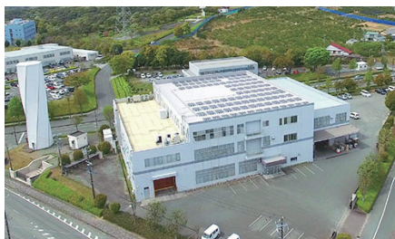
新都田工場 屋根を利用した太陽光発電パネル 発電設備出力: 49.5kW 面積: 1,000㎡
