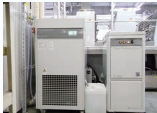
湿し水循環装置と高性能 フィルターろ過装置
