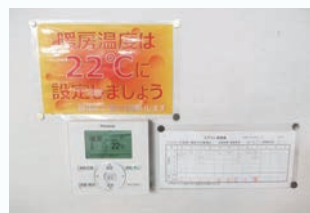
空調設定温度啓発表示とフィルター清掃 フィルター清掃の確認は、月末パトロールで実施
