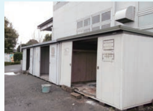
産業廃棄物保管倉庫
