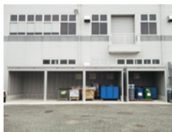
新都田工場廃棄物保管倉庫2018年7月改修
