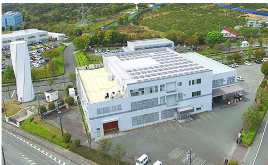
新都田工場 太陽光パネル 発電設備出力49.5kW 2014年1月稼働
